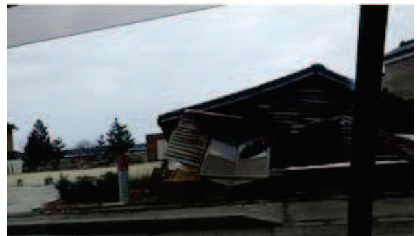
石川県七尾市穴水周辺 潰れた木工所
