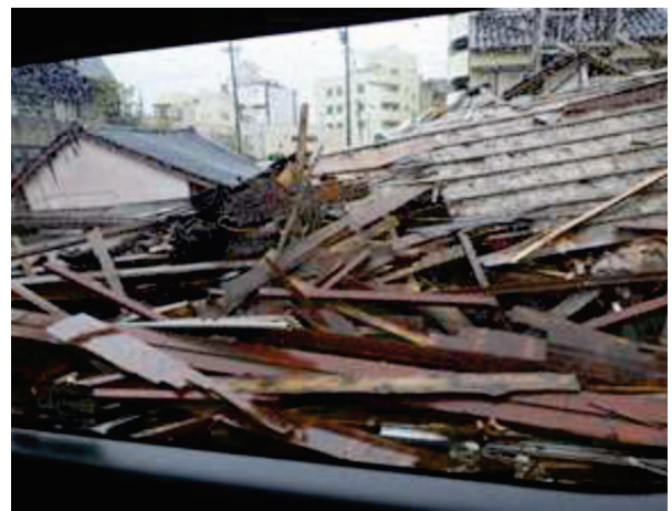
石川県七尾市穴水周辺 潰れた家
